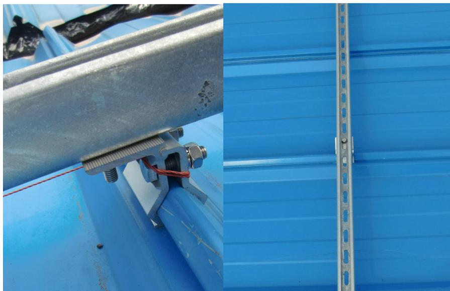
图 7.3-1 夹具及镀锌钢条形横梁方案照片
