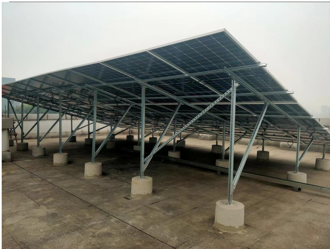
图7.3-1屋面板上设置砼支墩方案照片
