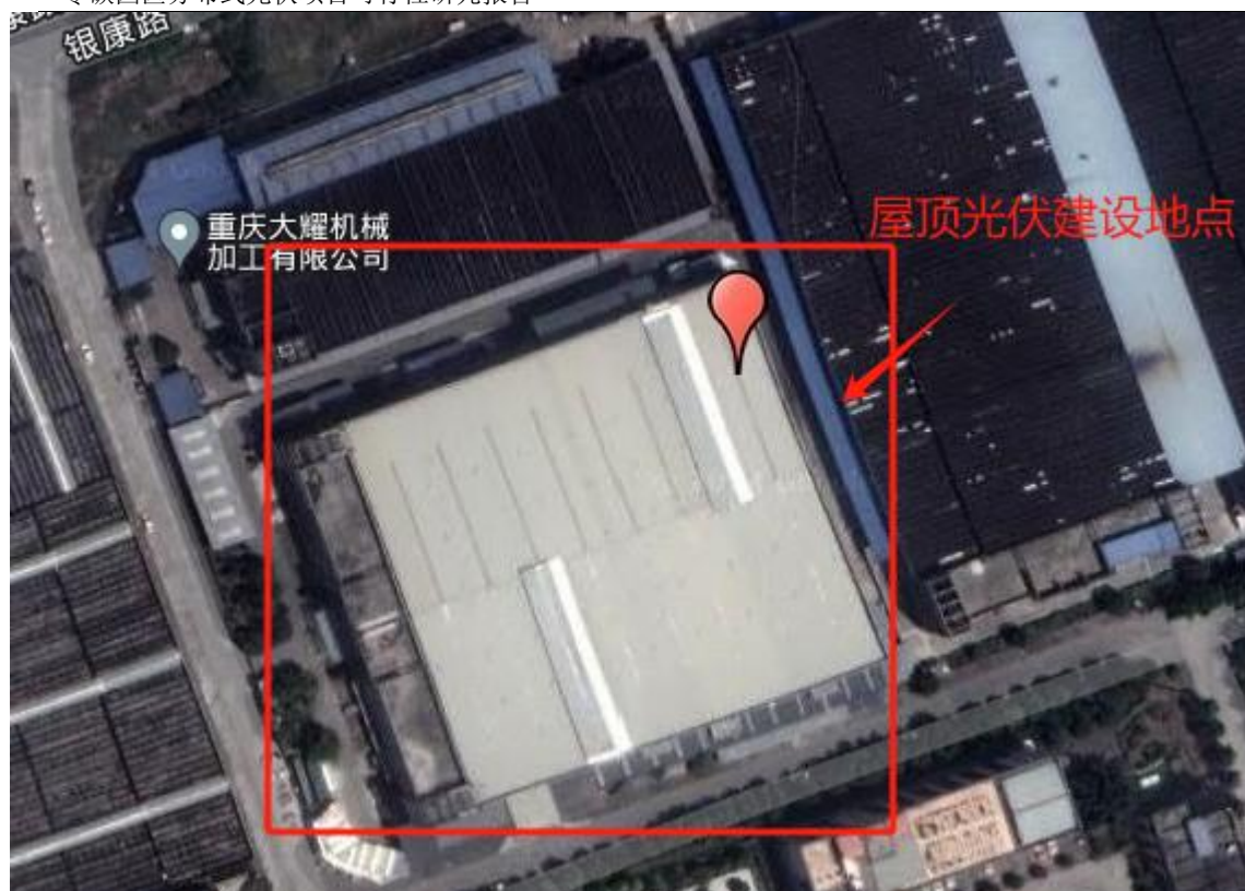
图3.1-2本项目现场实际照片
