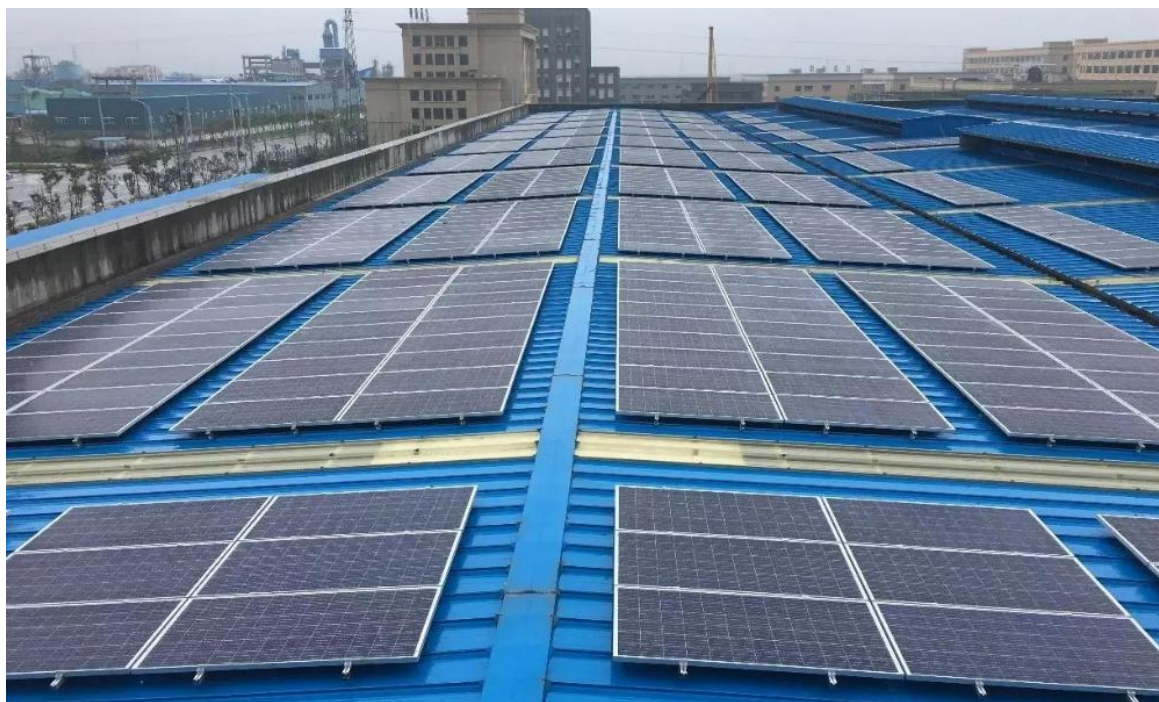
图7.3-1屋面板上设置砼支墩方案照片
